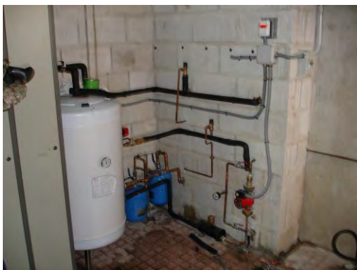
Vestuarios traballadores obras
