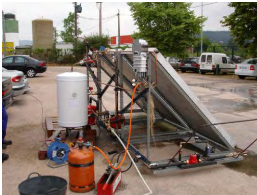
Fabricación soportes térmica
